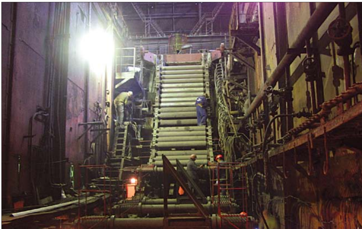
Рис. 10. Общий вид МНЛЗ с установленными шаблонами
